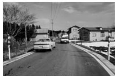
【整備後・和野平井賀線】道路の舗装と両側側溝を整備。車のすれ違い時の安全性が向上するなど改善が図られた
