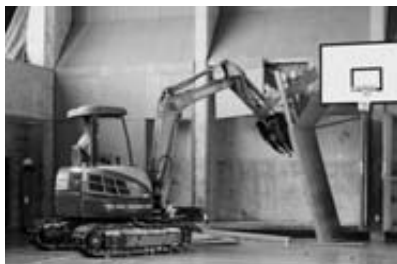
解体工事が始まった田野畑中体育館
