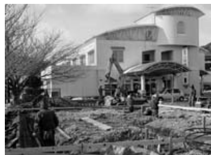
工事が進む薬局施設（2月18日撮影）
